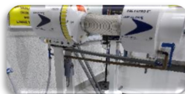
APLICAÇÃO TÍPICA DO PRÉFILTRO NA HORIZONTAL.
